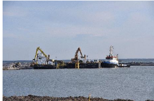
Byggeriet af den faste forbindelse er for alvor gået i gang!
